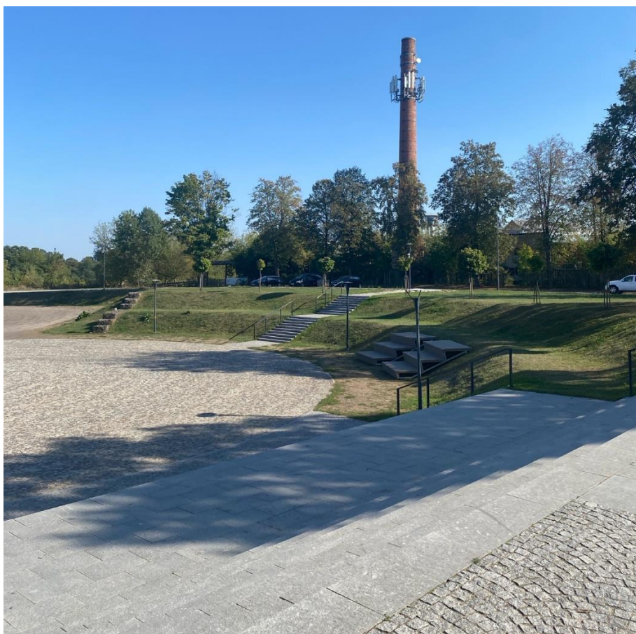
Rycina 2. Brak podjazdów dla wózków przy Amfiteatrze
