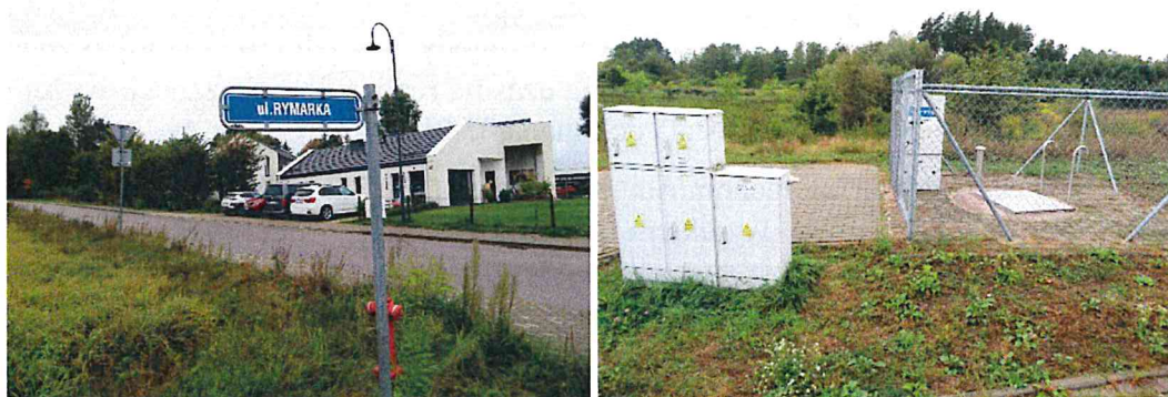
Zdjęcia nr 3,4: Ul. Rymarka (odc. E-F) oraz przepompownia ścieków.
