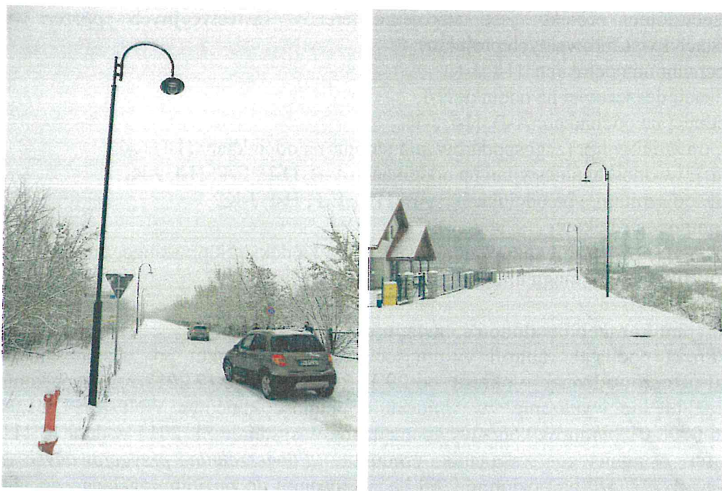
Zdjęcia nr 1-2. Ul. Kodeksu Supraskiego (odcinek A-B i odcinek D-E)
