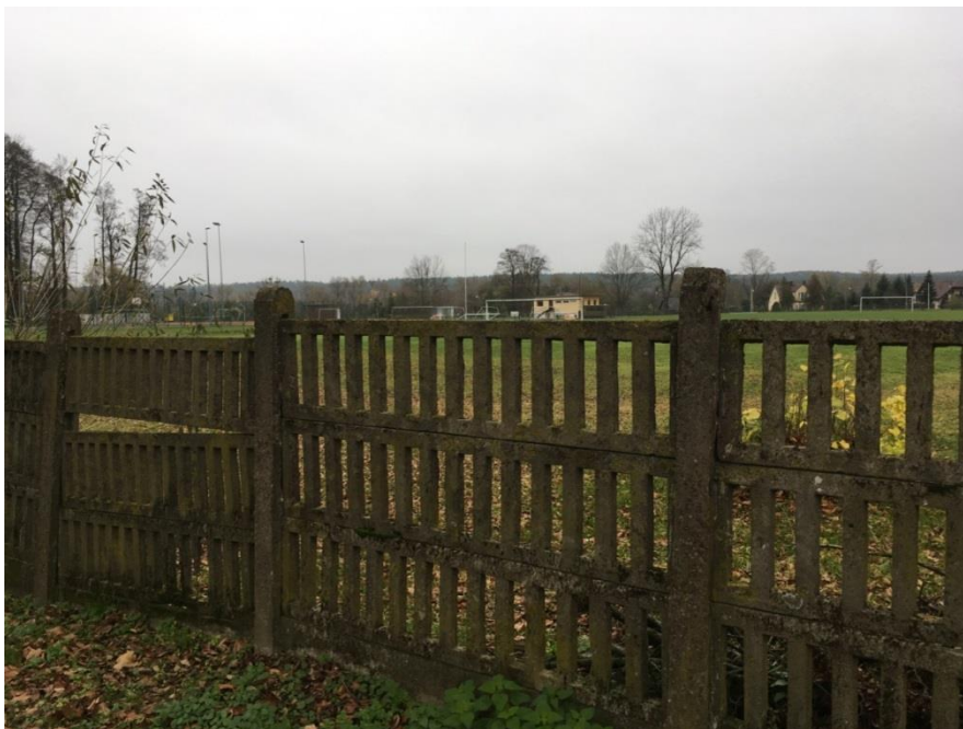
Ogrodzenie Stadionu Miejskiego w Supraślu (widok od strony Parku Saskiego)
