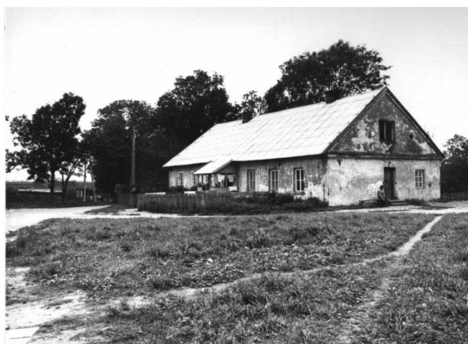
Zdjęcie 9 Widok na dwór w Sobolewie - stan z 1988 r.
