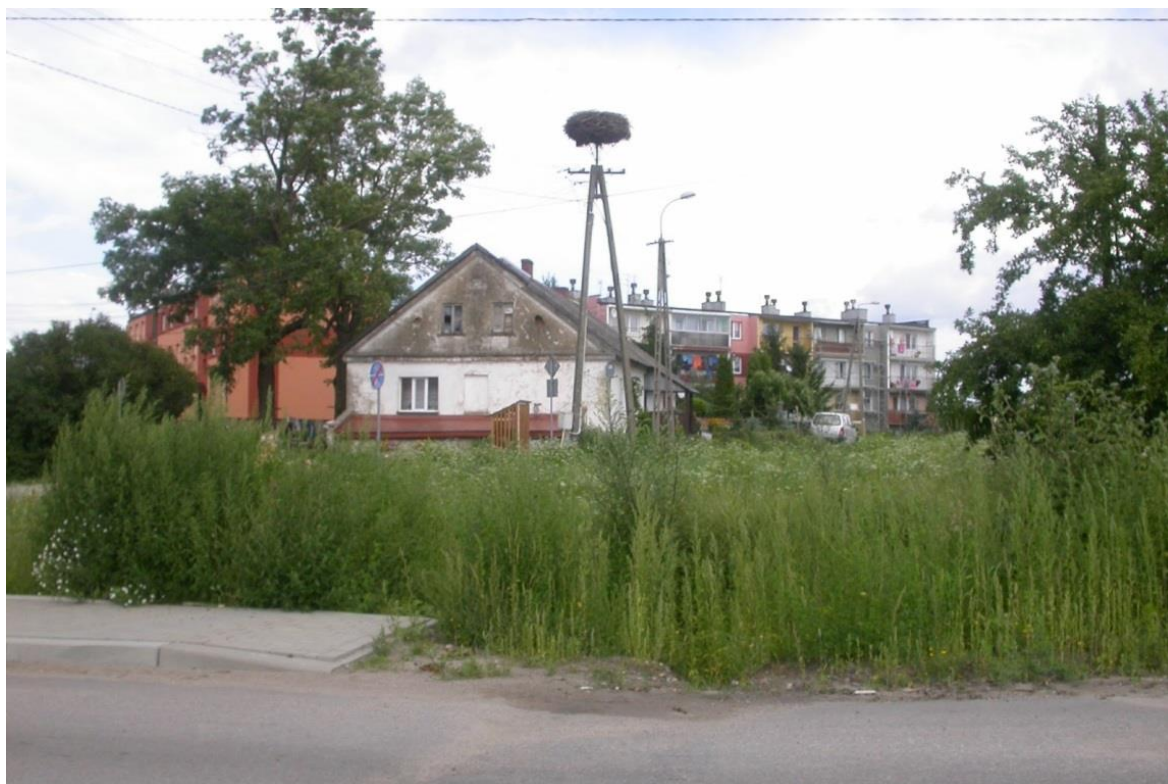
Pozostałości po Folwarku w Sobolewie, w tle bloki przy ul. Henrykowskiej (dawny PGR)
